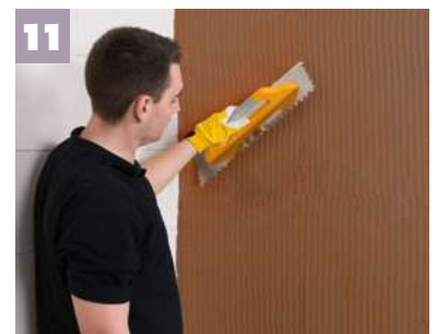
Jute- oder Glasfasergewebe mit einer Maschenweite von 7x7 als Armierungslage einbetten
