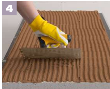
Wichtig ist der vollflächige Auftrag des Terrafino Haftlehms quer zur Ansetzrichtung
