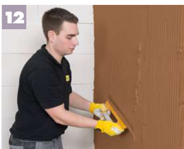
Abziehen der Armierungsschicht
