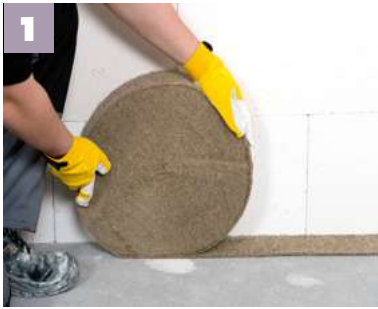
Zur Entkopplung wird ein Hanf Filzdämmstreifen auf dem Boden ausgerollt
