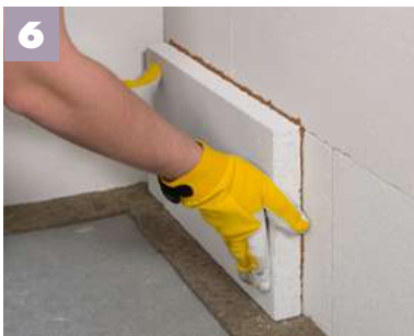
Terrafino KOMPAKT+ nach dem Andrücken 2 bis 3 cm verschieben, sodass die Stege umklappen und eine vollflächige Verklebung gewährleistet wird.
