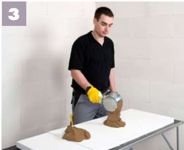
Ausreichend Terrafino Haftlehm auf die Terrafino KOMPAKT+ auftragen
