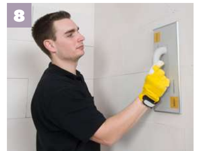
Eventuelle Unebenheiten können mit einem Schleifbrett egalisiert werden. Fehlstellen sind mit dem Terrafino BASE Lehmoberputz auszubessern
